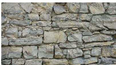
Il restauro, i rappezzi ed i nuovi muri intonacati devono essere eseguiti esclusivamente in malta a base di calce, calce aerea o utilizzando malte preconfezionate denominate intonaco di calce idraulica, escludendo l'utilizzo di
