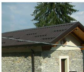
Soluzione in lamiera di tipo compatibile, ma con tecnica e caratteristiche non ammissibili per pendenza e sporgenze rispetto ai tetti in piodè
