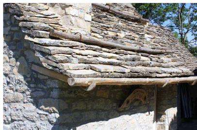
Nella quasi totalità dei casi tali coperture sono andate perse e sono state trasformate. In alcuni casi si è conservato l'impianto murario con sostituzione del manto con lamiera o tegole di cemento; in altri casi è stata alterata la pendenza originaria ed è stato ancora realizzato un nuovo manto in tegole o lamiera; in altri ancora si presenta l'intero tetto crollato.
