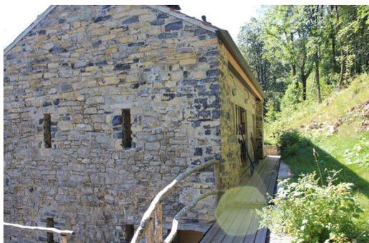
Il complessivo intervento di riqualificazione del manufatto originario mostra la compatibilità tra elementi trattati con materiali e tecniche della tradizione con inserimenti con l'uso di elementi della tecnica contemporanea quali il muro in C.A. gettato a vista.
